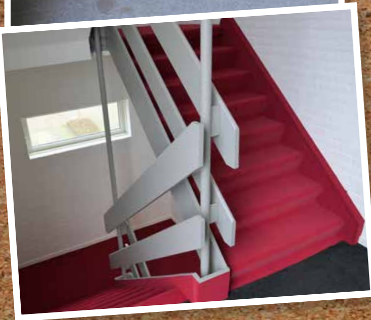
Boven de oude situatie, onder trappenhuis na renovatie
