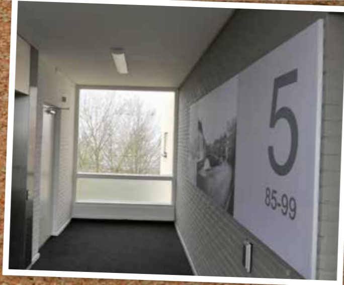
Boven de oude situatie, onder het trappenhuis na renovatie
